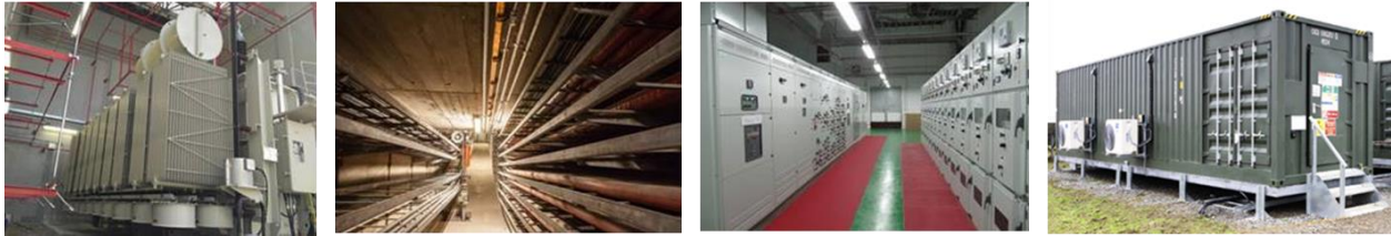
Abbildung 10: Beispiele für andere Bereiche, die sich durch die gleiche Art der BBA absichern lassen. Von links nach rechts: Transformatoren, Kabelkanäle, Schaltanlagen, stationäre Energiespeicher. Fotos: FOGTEC.
