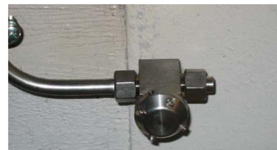
*Hochdruckwassernebel-Systeme bekämpfen Brände mit kleinsten Tropfen unbehandeltem Trinkwassers, welche sich ähnlich wie ein Gas im Löschbereich ausbreiten.*
