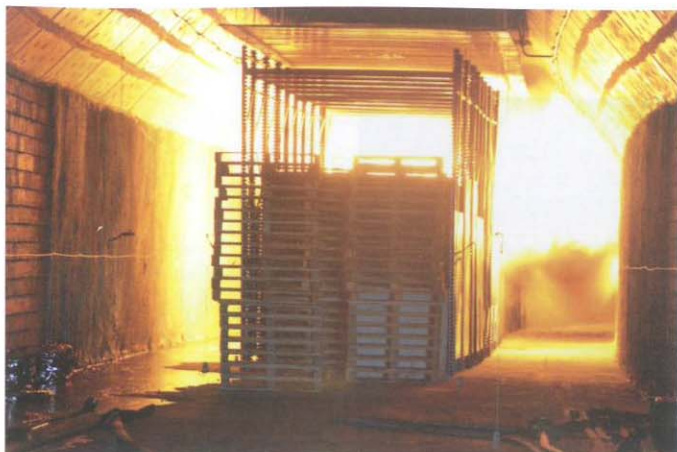
Bild 3. Großbrandversuch für den Eurotunnel
